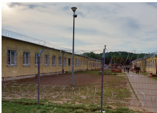
Zasieki concertina na placu spacerowym w TSOC w Wędrzynie
